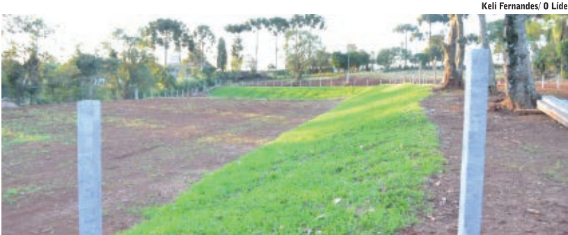
Empresa contratada também trabalha na revitalização do viveiro municipal, que fica junto ao Parque Rineu Gransotto, e, após a conclusão desse trabalho, o valor do contrato vai diminuir
