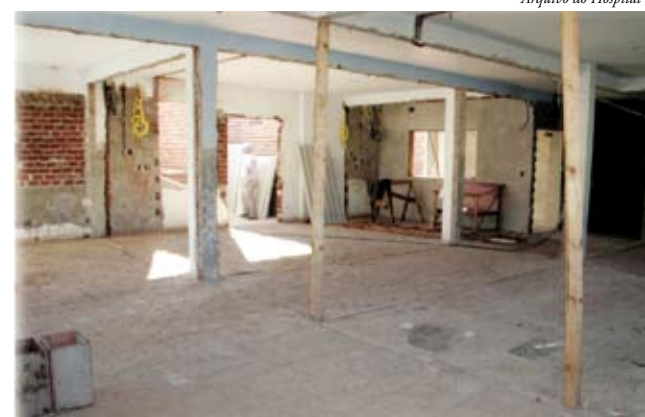
Reforma realizada em maio de 2006 para instalação da UTI
