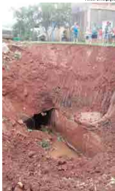
Córrego antigo acabou rachando e ocasionando o desmoronamento
