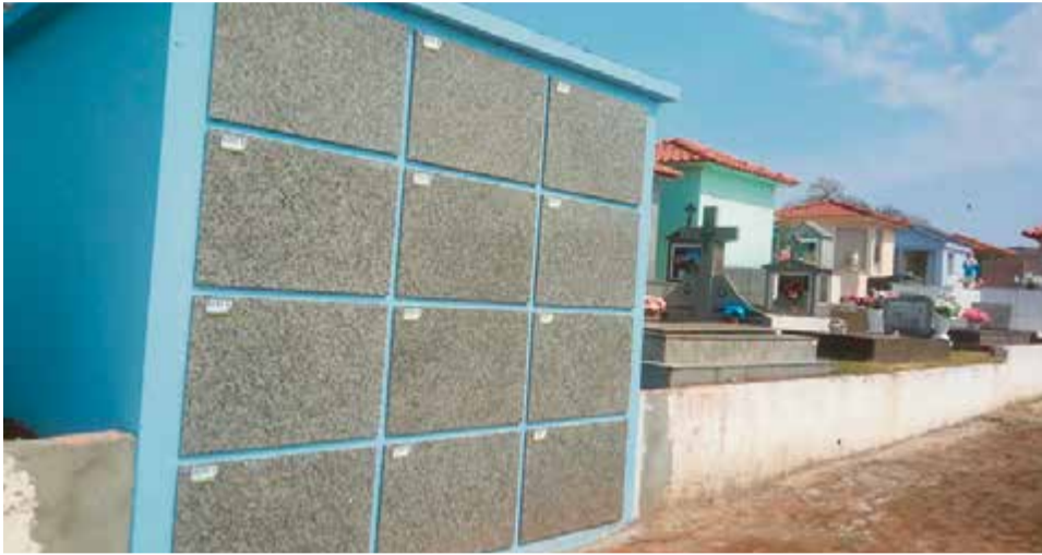
Dois gavetários já foram construídos
