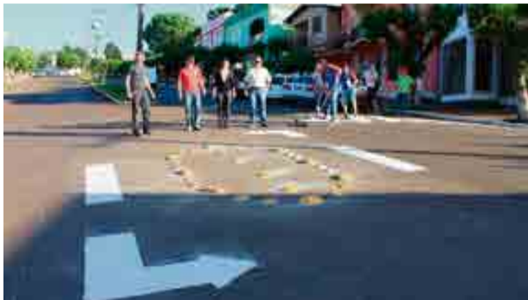
Representantes da Secretaria de Obras e Infraestrutura e Demutran acompanharam trabalhos
