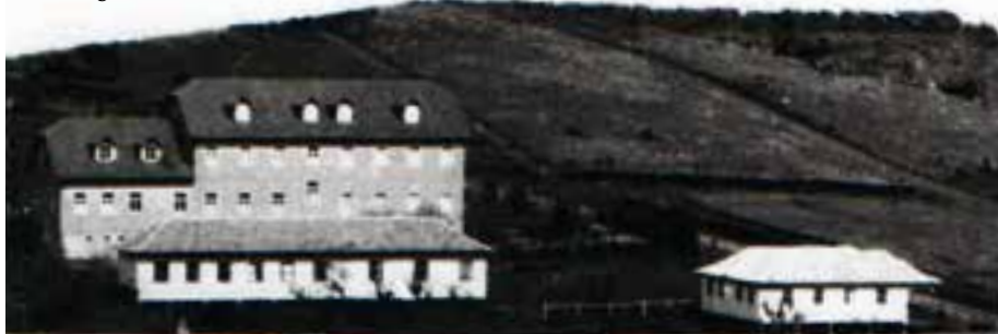
As instalações da época com 5 salas de aula
