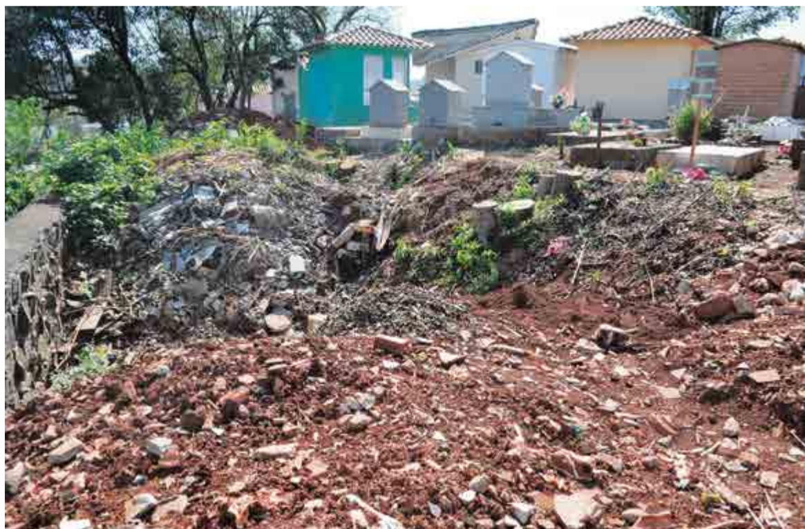
Espaço atrás dos banheiros está sendo aterrado para construção de novos túmulos
