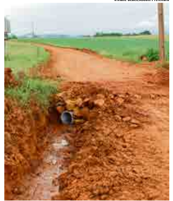
Colocação de tubos e patrolamento das estradas foram algumas das ações realizadas
