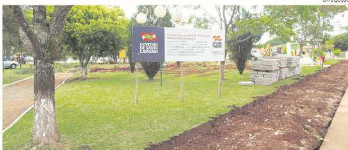
Divulgação Obra prevê troca de calçadas, iluminação e novo paisagismo
