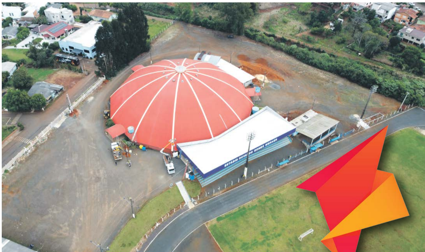
Local passa por melhorias e preparação para receber o evento
