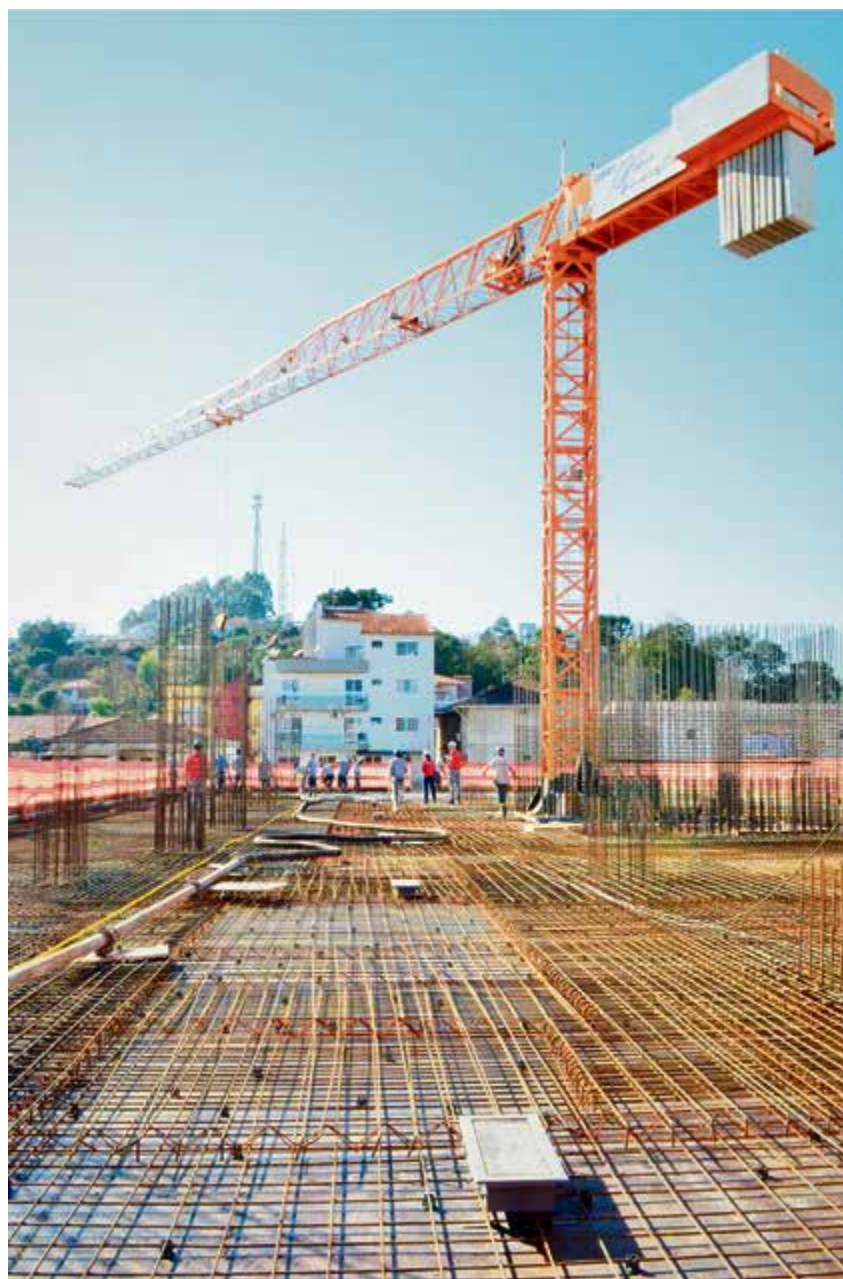
Foto do concreto da 3ª laje do Gran Moralle
