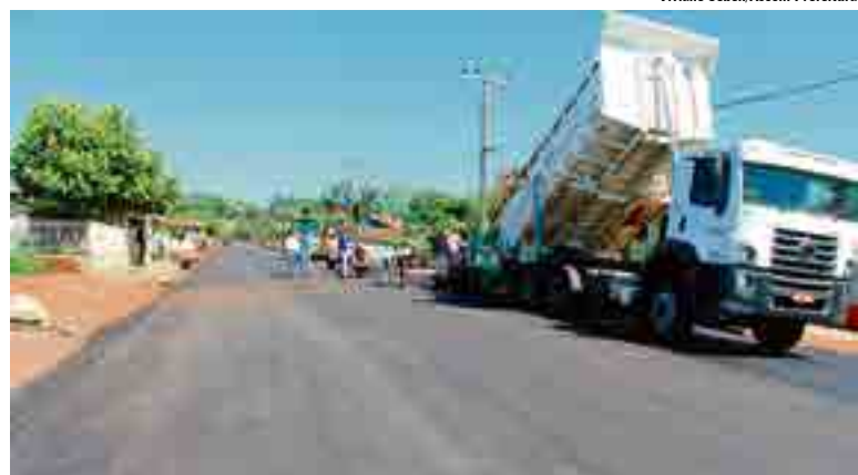
Asfalto vai viabilizar tráfego de veículos e garantir qualidade de vida aos moradores
