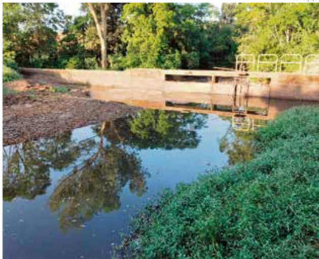
Registro no local de captação de água, mostre baixo nível do Rio Jundiá
