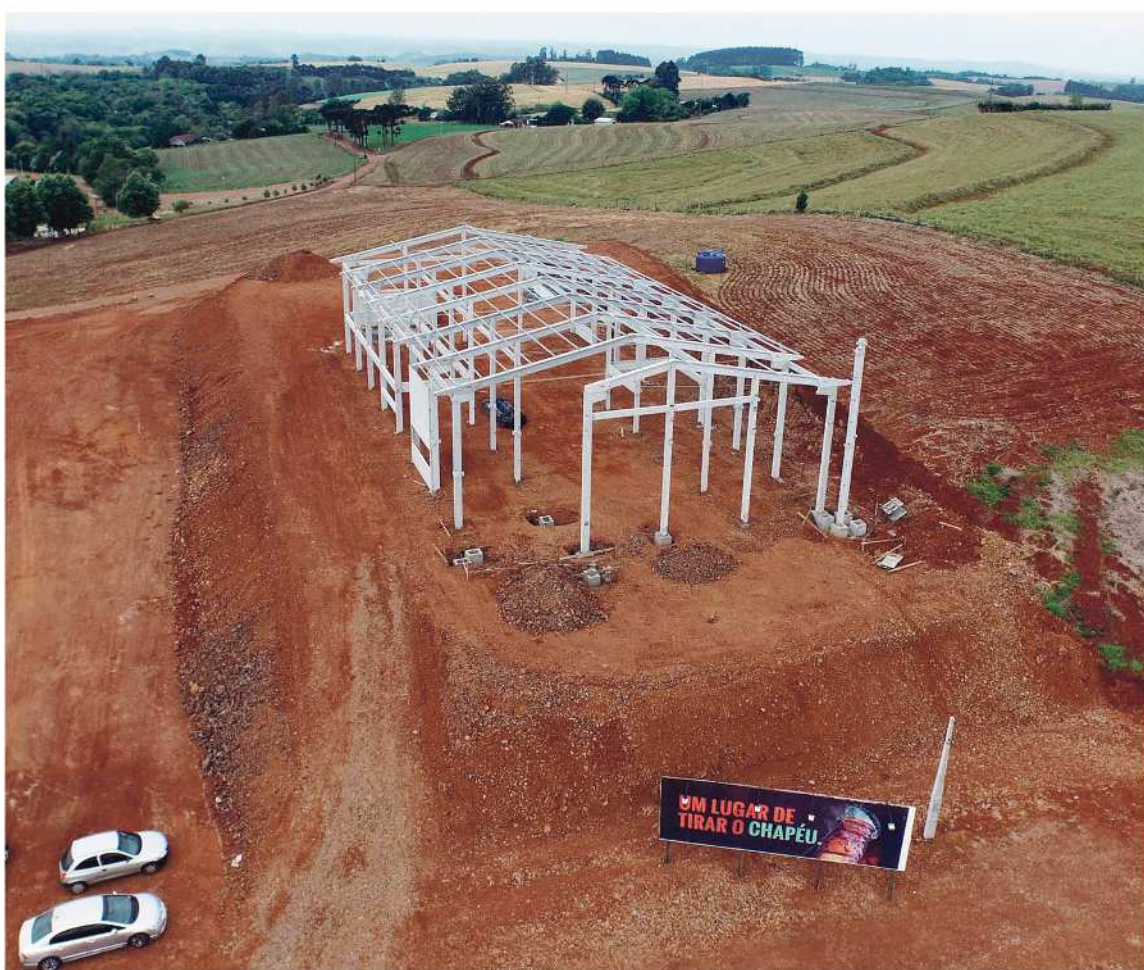
Big John Cervejaria está sendo construída na Linha Cruzinhas, entre São Miguel do Oeste e Descanso
