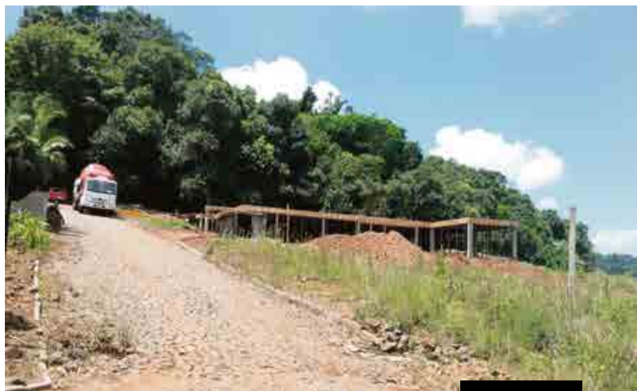
Construção da sede do Cras
