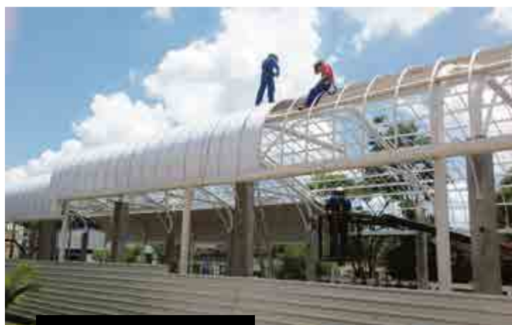
Obra da rua coberta está sendo executada
