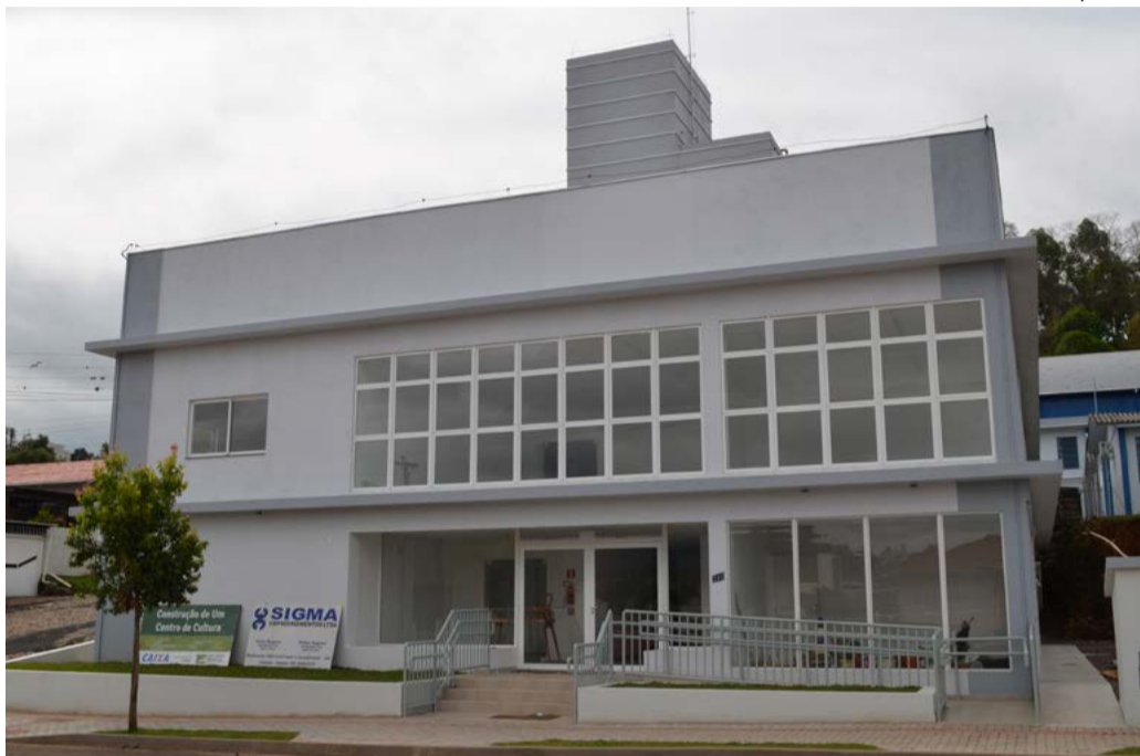
Estrutura fica localizada na Avenida Presidente Kennedy
