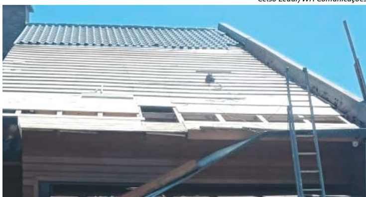
Homem estava efetuando a troca do telhado da casa
