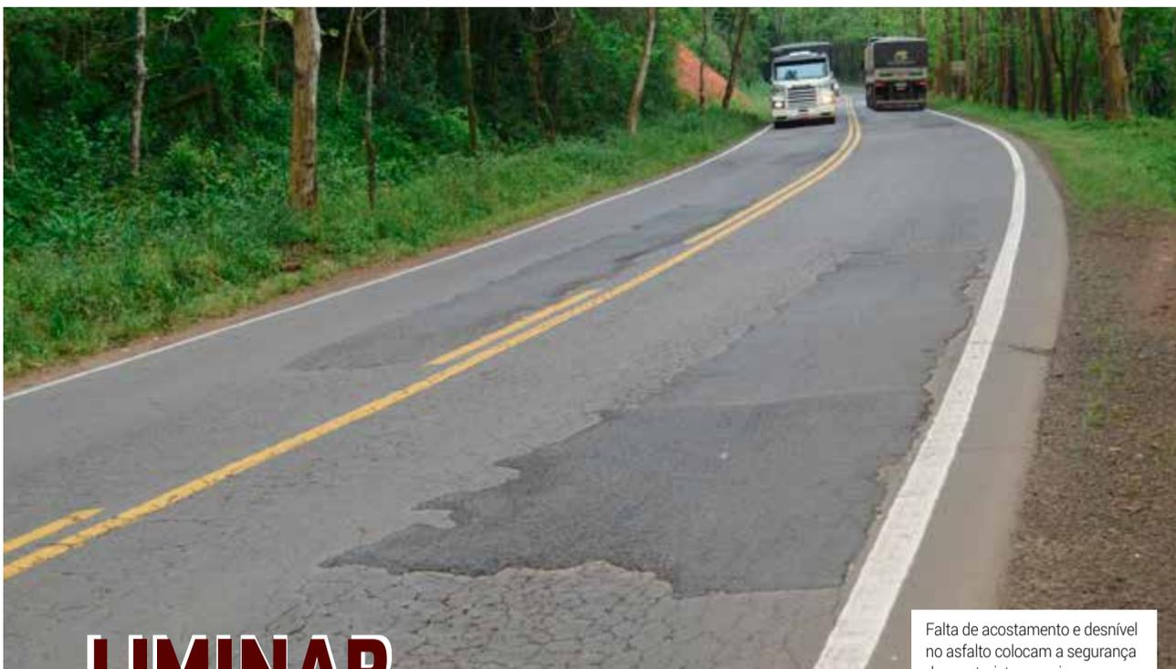
Falta de acostamento e desnível no asfalto colocam a segurança dos motoristas em risco
