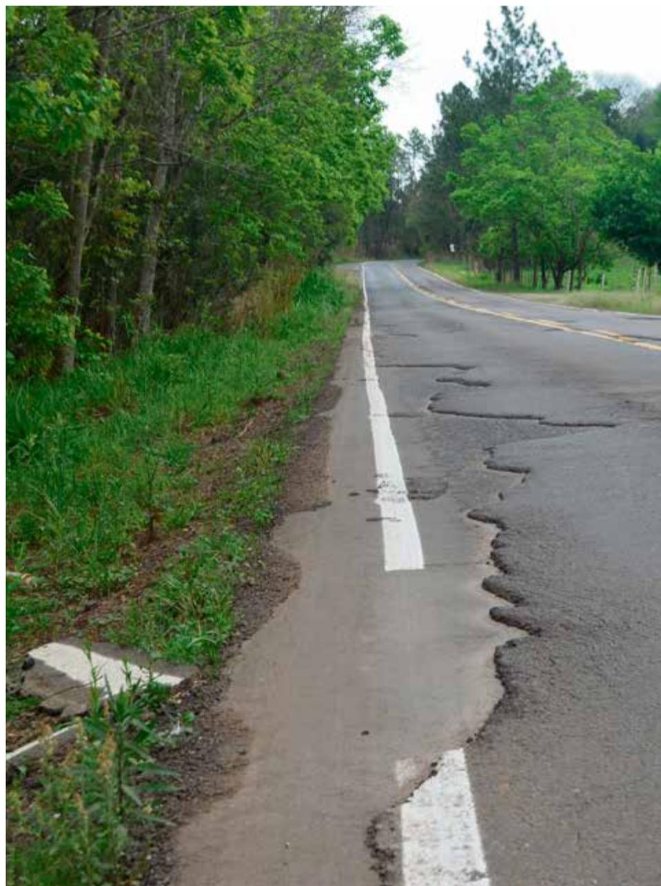
Camada asfáltica está deteriorada em diversos trechos
