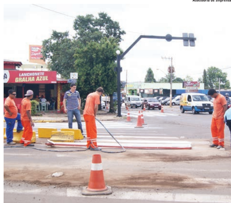
Sinalizações e faixas de pedestres estão recebendo novas pinturas
