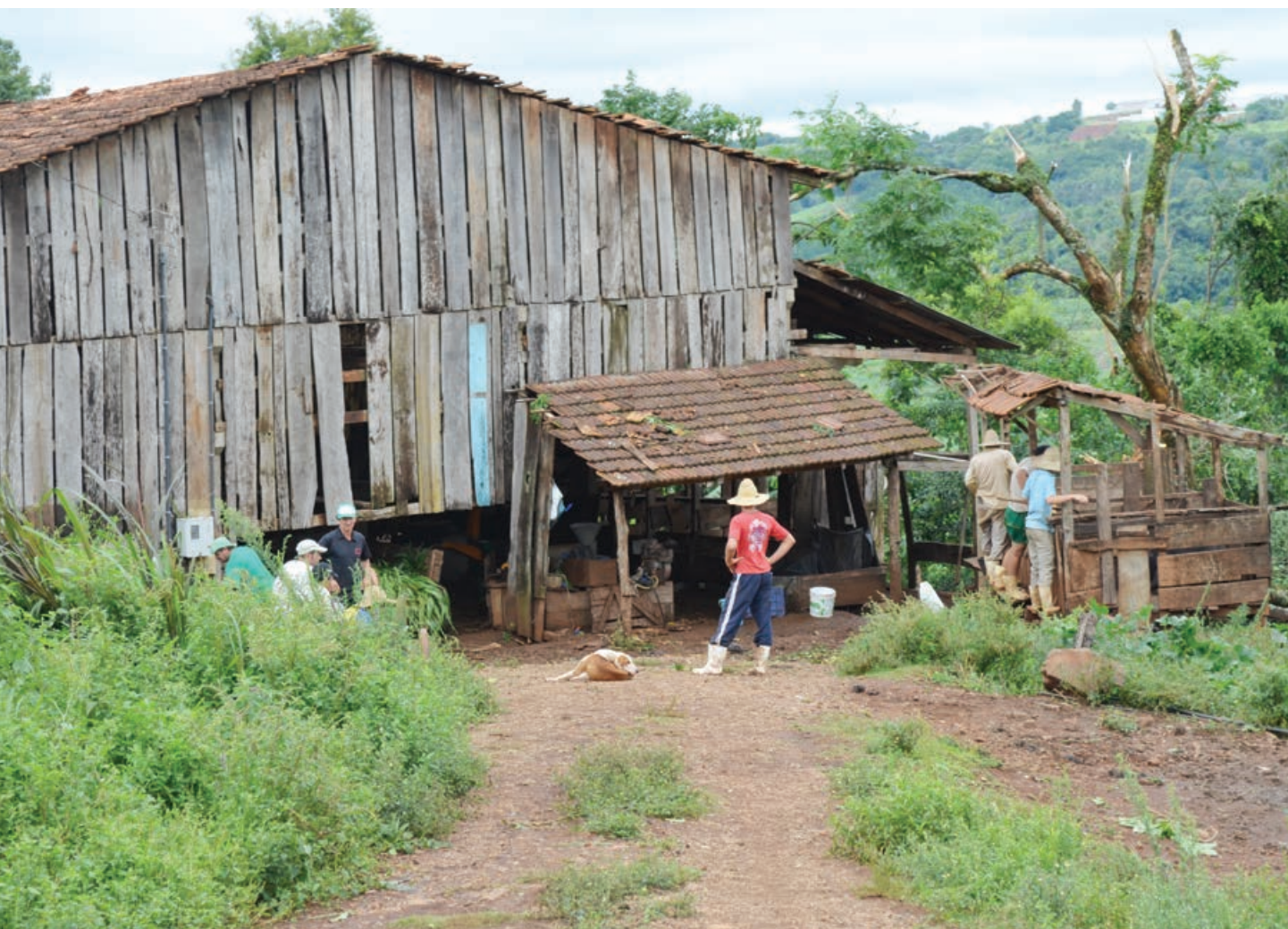
Vizinhos ajudaram na remoção das madeiras para a reconstrução do galpão que já havia ficado destruído com a passagem do tornado em Guaraciaba, no ano de 2009
