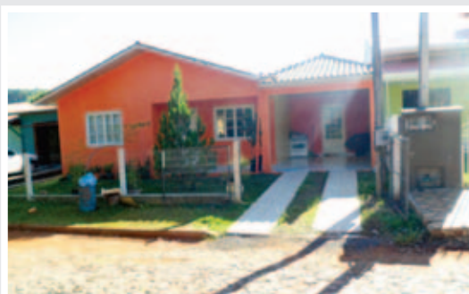
Terreno com duas casas no Bairro Floresta em Maravilha
