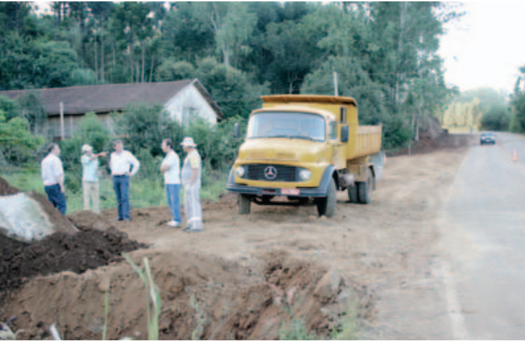
Escavações, limpeza do terreno e transporte de materiais estão sendo feitos
