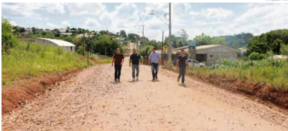
Medições e levantamentos topográficos do trecho começaram a ser feitos
