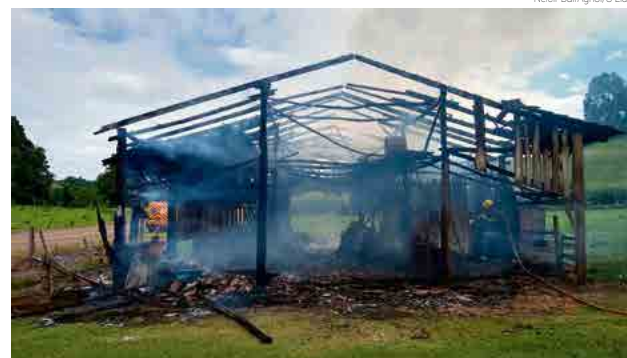
Corpo de Bombeiros controlou fogo e fez o rescaldo da estrutura
