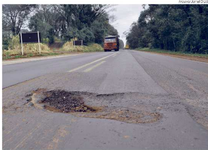
Após licitação, haverá estudo sobre as rodovias para melhorias
