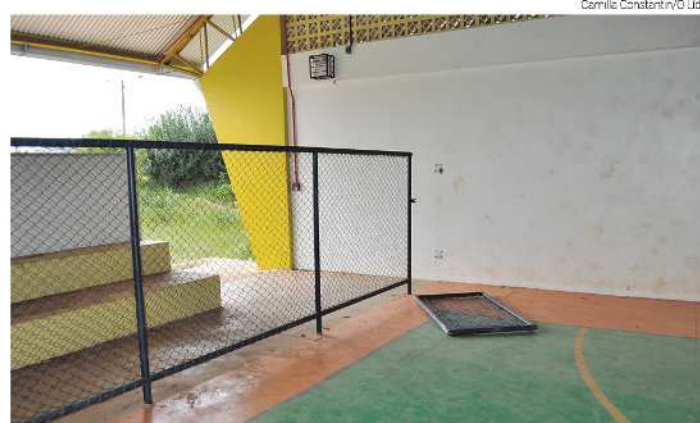
Obra teve investimento de aproximadamente R$ 500 mil
