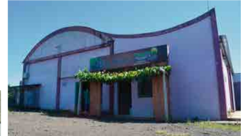
Empreendimento está localizado na Linha Vila Nova
