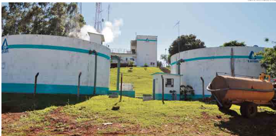
Estação de tratamento será reformada
