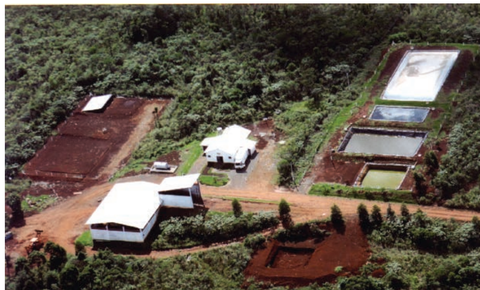
Unidade de Tratamento - Autoclave, do Aterro Sanitário de Anchieta/SC
