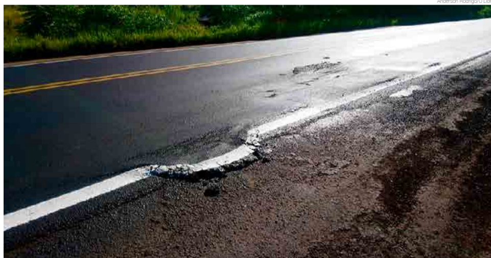
Asfalto já recebeu pintura e está danificado nas proximidades do Corpo de Bombeiros de Pinhalzinho
