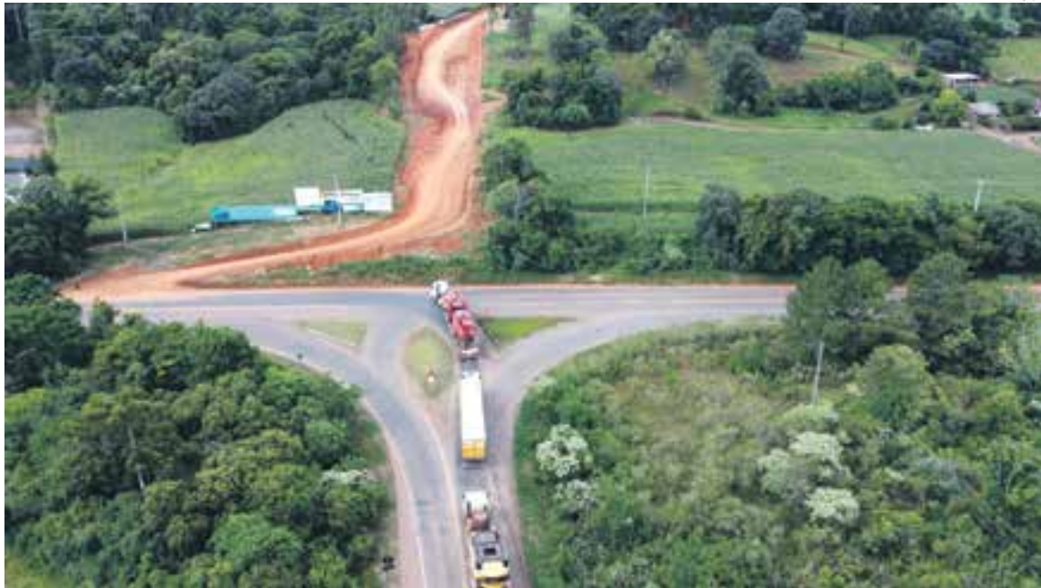
Obra do contorno viário já está em andamento
