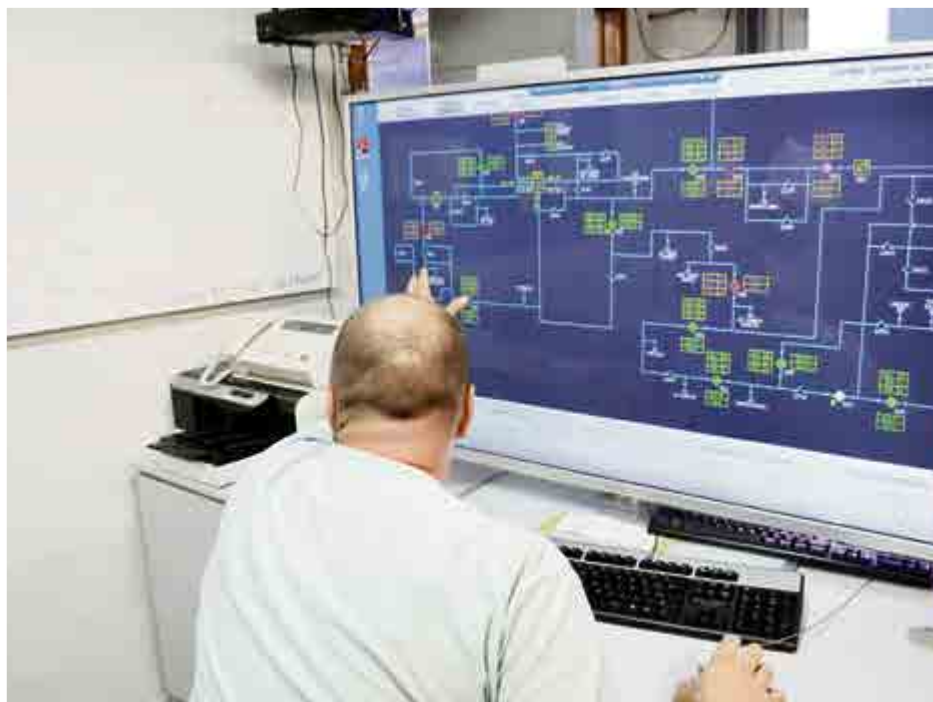
Hoje a Celesc trabalha na automação das redes principais e em algumas localidades já é possível “abrir e fechar” chaves pelo computador, mantendo o abastecimento ou diminuindo o número de unidades afetadas
