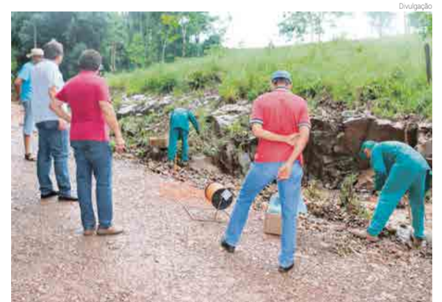
Trabalho de detonação de rochas na Linha Consoladora
