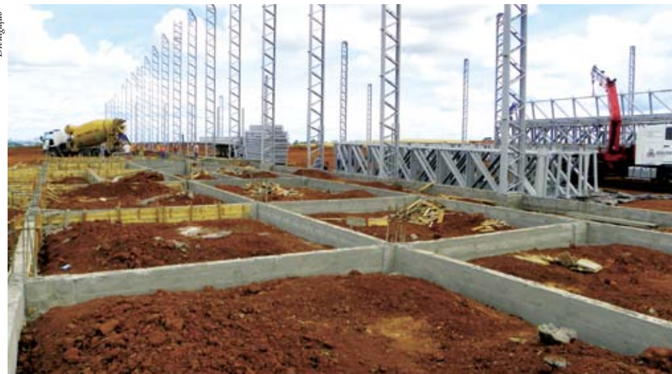
Construção da estrutura está acelerada
