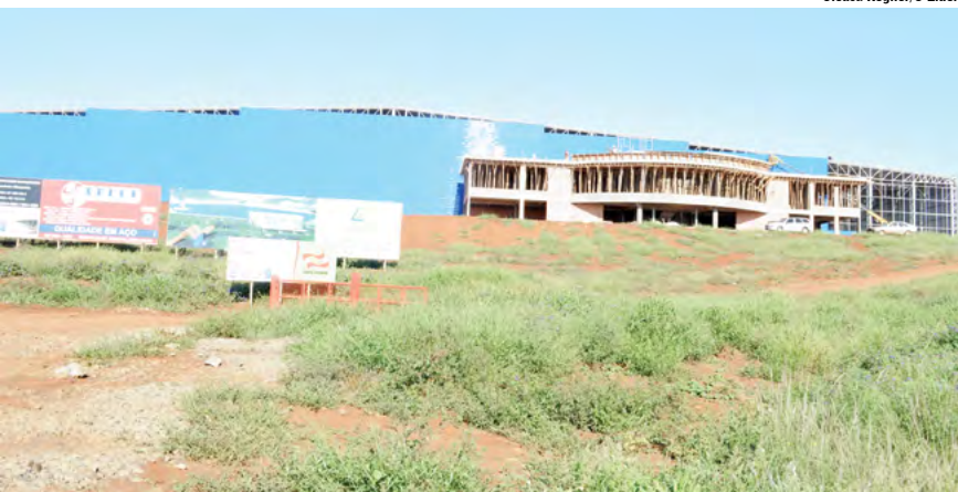
Avioeste está construindo sua indústria em Cunha Porã
