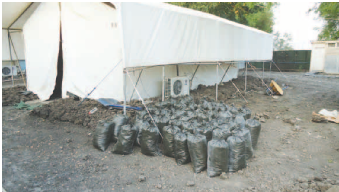
Sacos de terra servem de calçadas na tentativa de transportar a lama que interdita todos os caminhos em pouco tempo de chuva.
