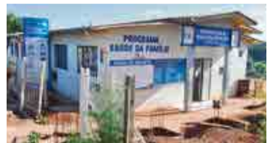
Estrutura da Unidade de Saúde passa por reformas
