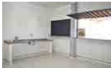
Copa já foi concluída
