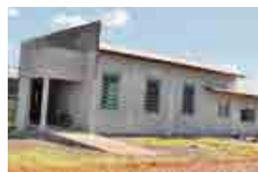
Sede da Igreja Adventista está sendo construída
