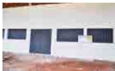
Parte da construção já concluída
