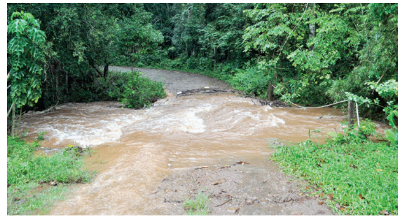
Chuvas danificaram pontes, bueiros e estradas
