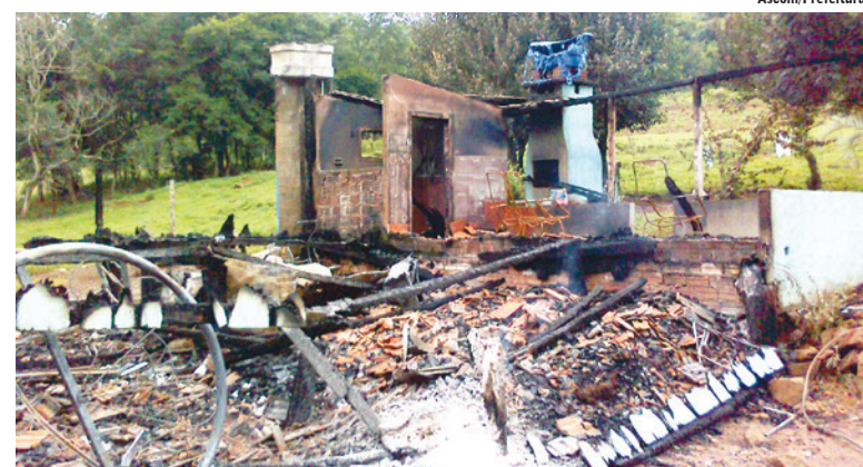
Residência de Lorivo e Rita Kluge ficou totalmente destruída
