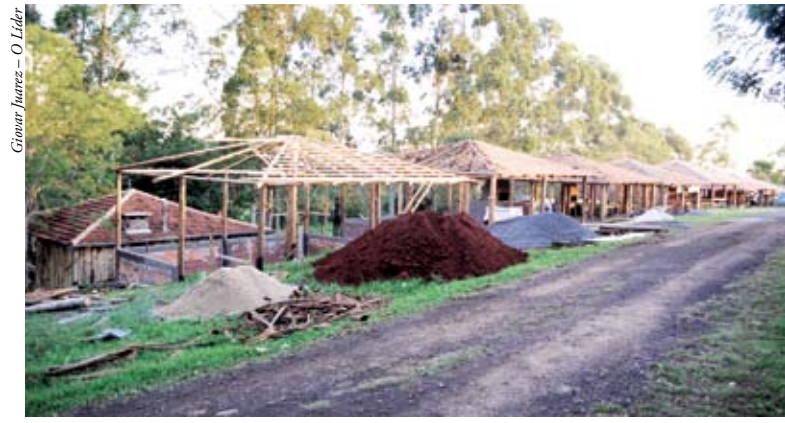
Alguns quiosques estão em fase de conclusão
