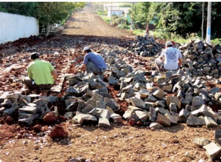
Calçamento em andamento na Rua Eduardo Sehnem
