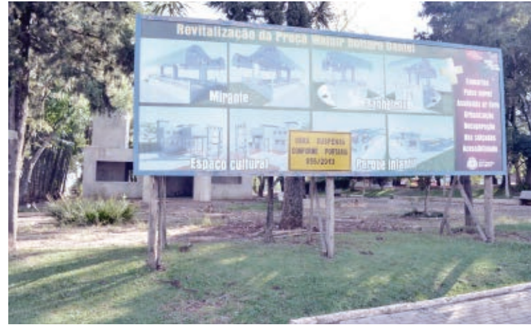
Obras seguem suspensas e não há previsão de retomada
