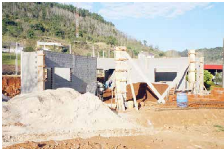
Obras da academia municipal estão em fase avançada
