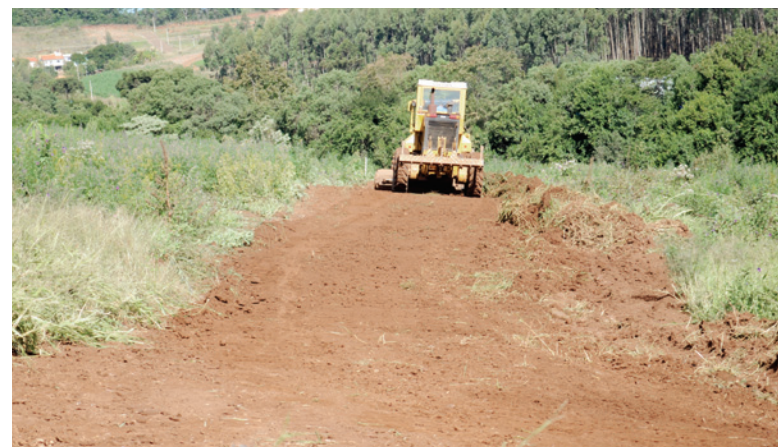
Máquinas já iniciaram as obras na tarde de segunda-feira
