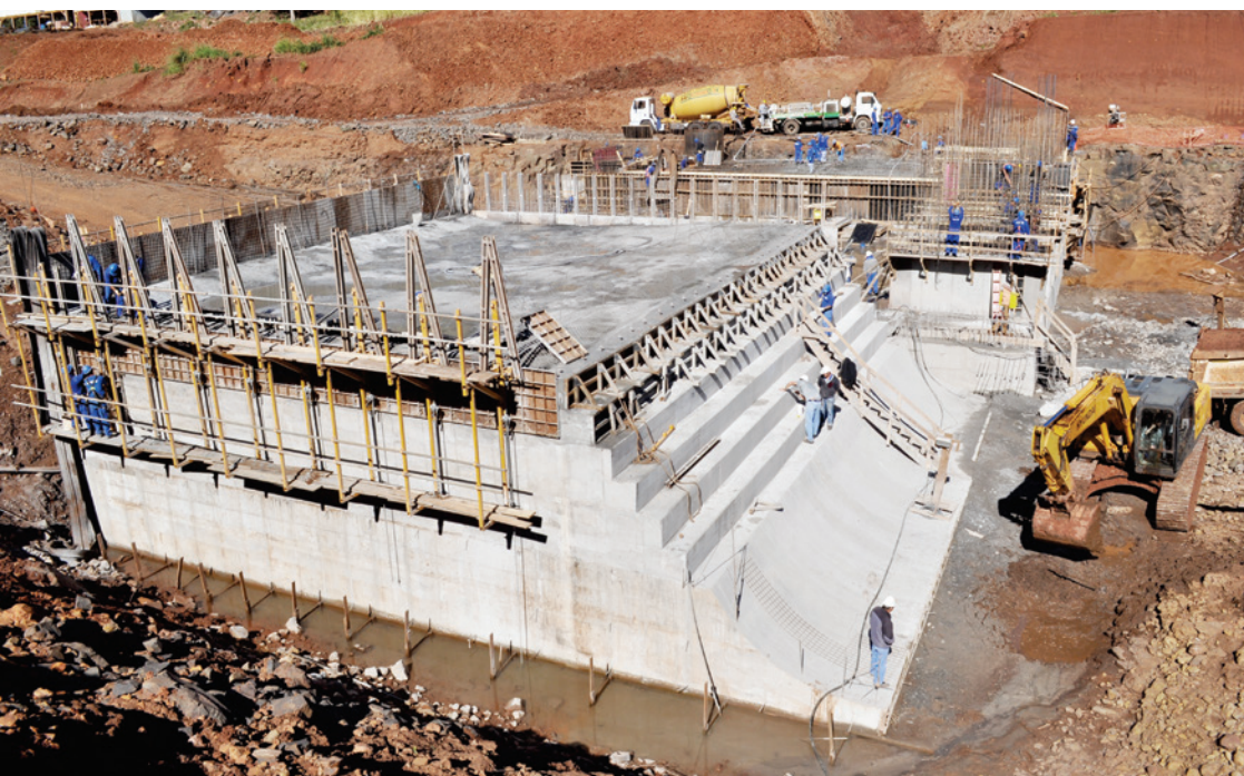
As obras estão ocorrendo na Linha São Jorge, interior do município de Romelândia
