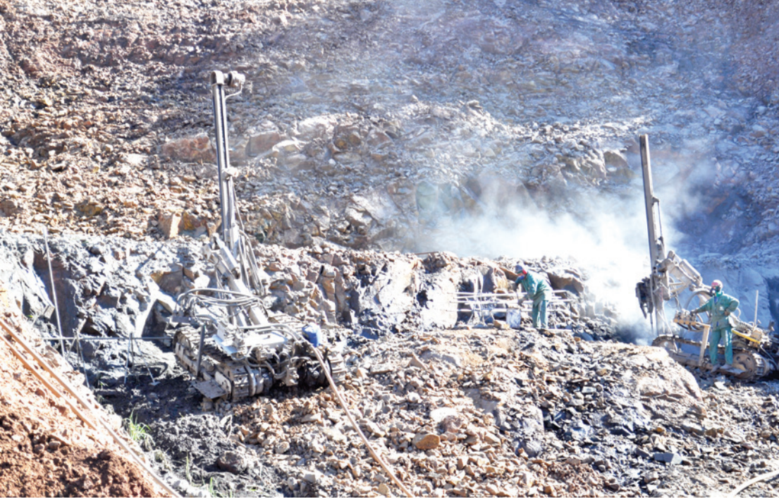
Uma empresa especializada está realizando as perfurações do túnel
