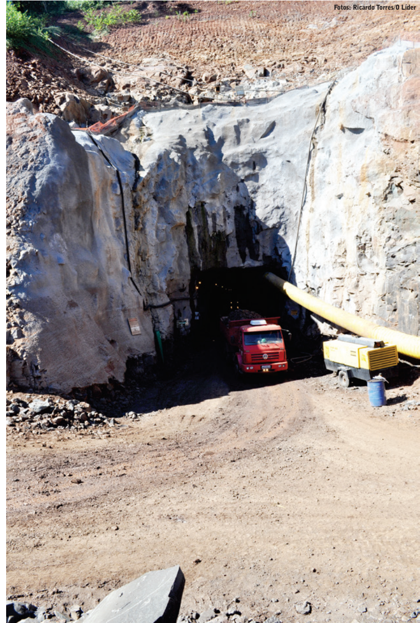
Trabalhos de perfuração estão ocorrendo em dois turnos 24 horas por dia
