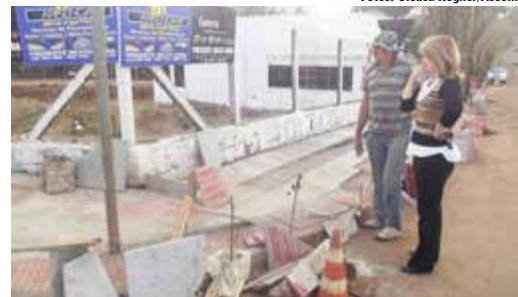
Obras da Casa Mortuária
