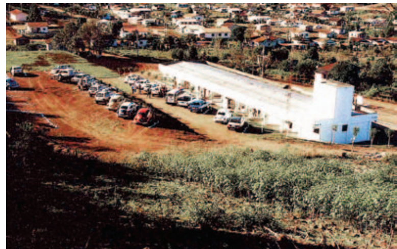
Estrutura da Polícia Militar quando foi construída
