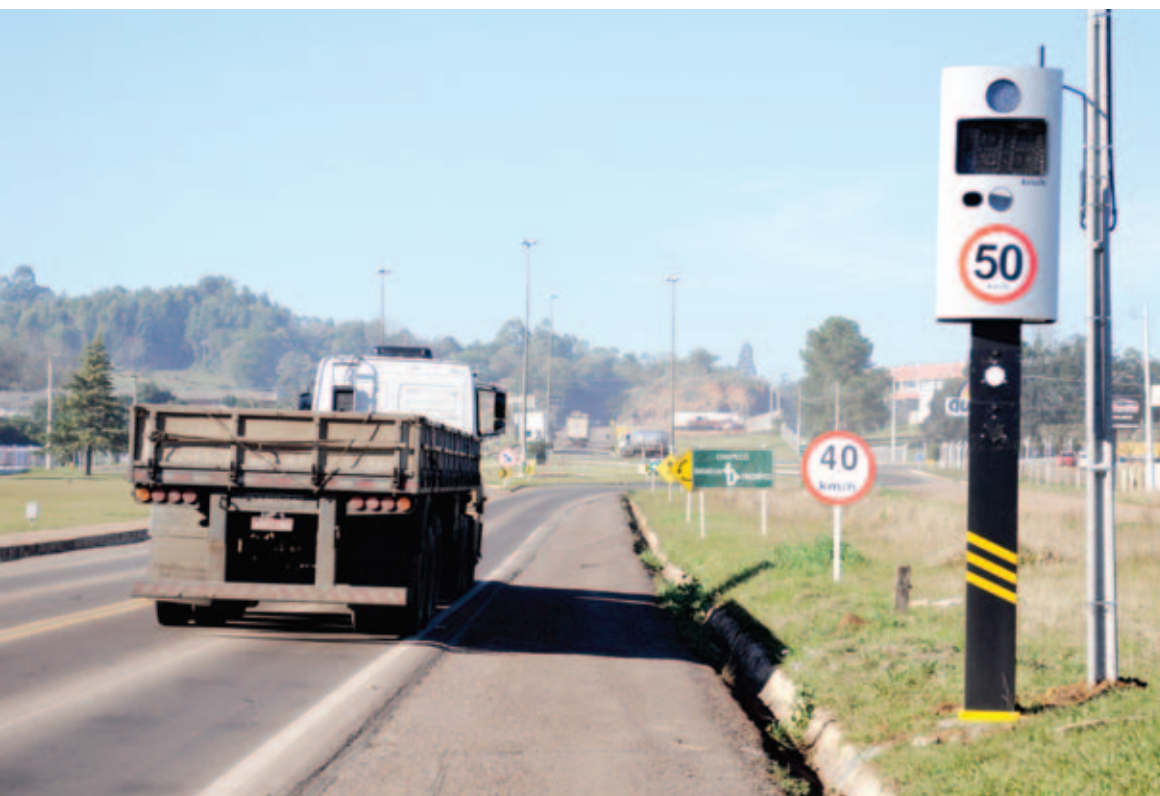
Ao todo 22 lombadas eletrônicas serão instaladas na BR 282
