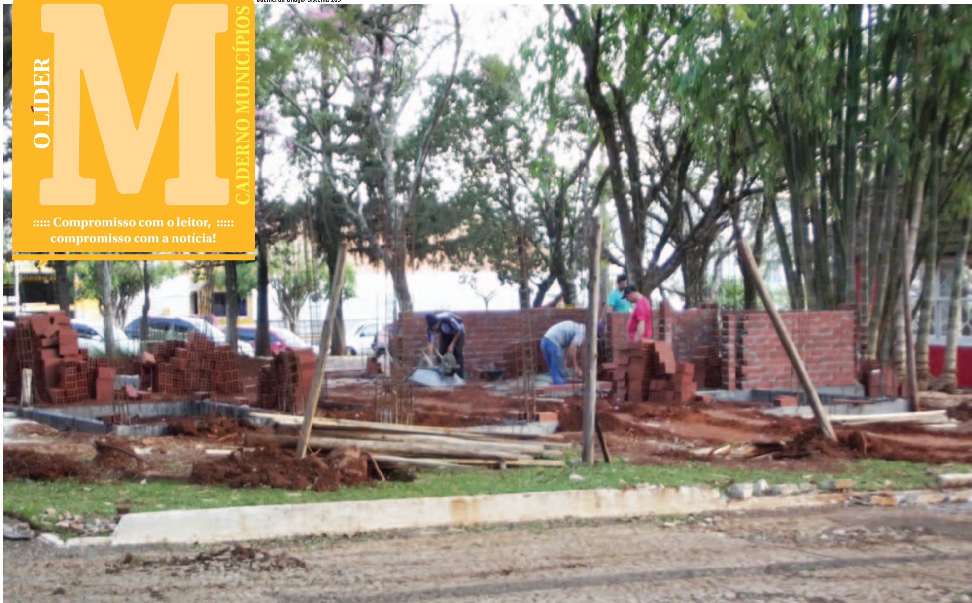
Dentro do projeto, está a construção de uma área coberta, play ground, lanchonete, banheiros públicos, palco retrátil, entre outros.
