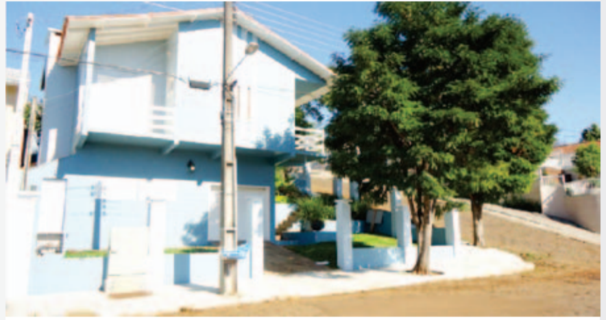
Lote urbano, com área de 420,00m 2 , com benfeitoria, uma casa de alvenaria, com 227,68m 2 , constando, 3 dormitórios sendo todos suítes, sala de estar, escritório, sala de tv, cozinha, espaço gourmet, área de serviço, banheiro social, garagem com portão de elevação com capacidade para 1 veículos, varanda, toda em lage. Localizado na Rua General Osório nº 1136, Bairro Panorâmico/Jardim, Maravilha/SC
