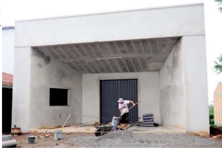
Obras do Centro Esportivo Educacional estão em ritmo acelerado
