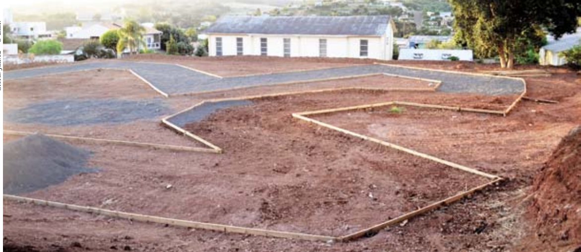
A construção está em andamento na Rua Princesa Isabel, esquina com a Avenida Sul Brasil
