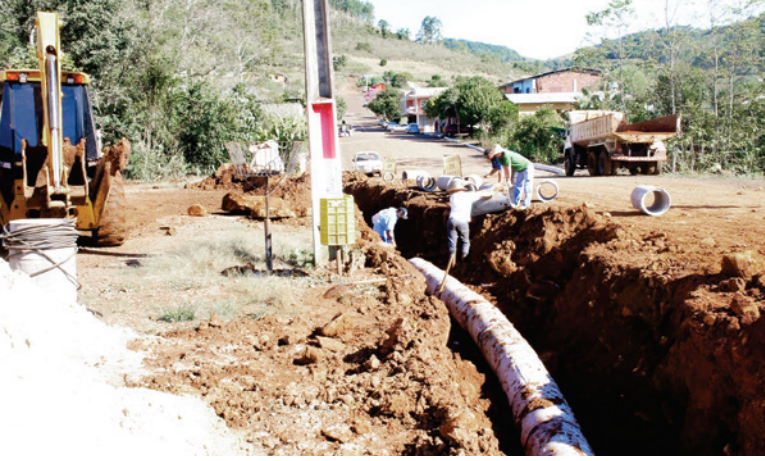
Equipe da Secretaria está trabalhando na colocação dos tubos
