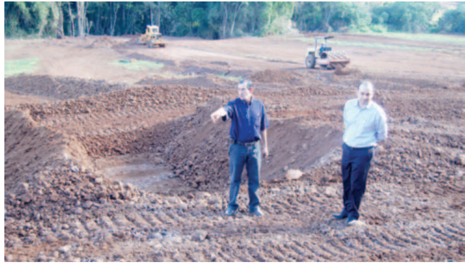
Vice-prefeito e o procurador geral do município acompanharam as obras
