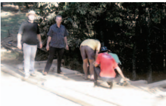
Vice-prefeito Wilson e o vice-prefeito de Cunhataí, Evelton, acompanharam as obras da ponte na Linha Barra Grande
