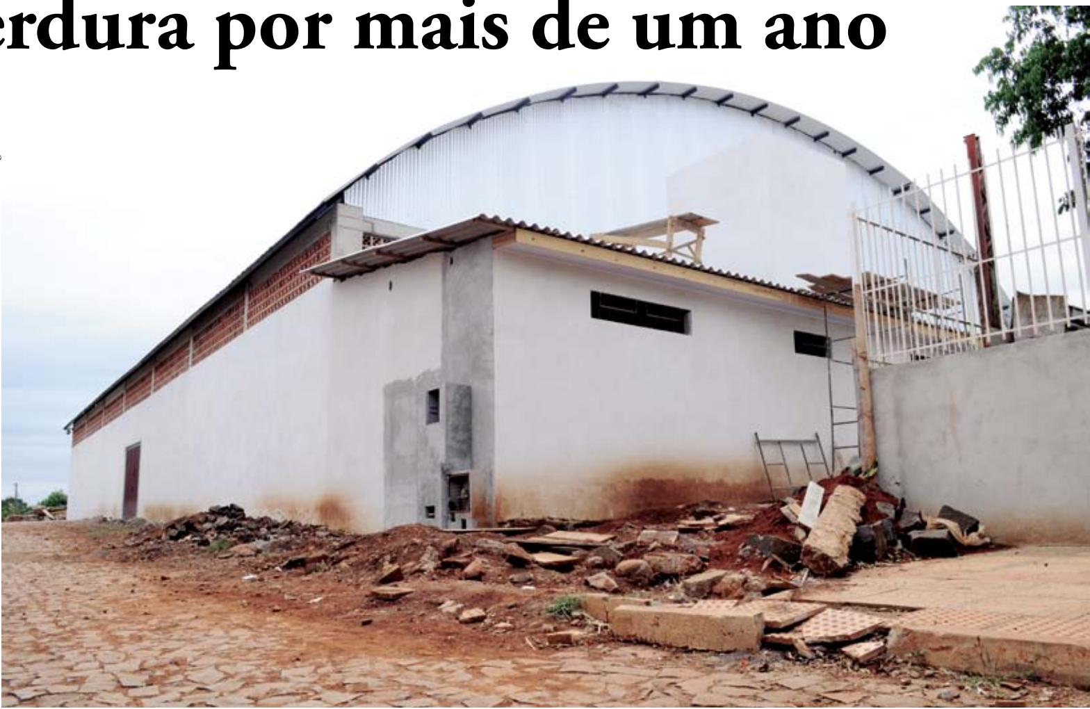
Ginásio continua fechado para o término das obras
