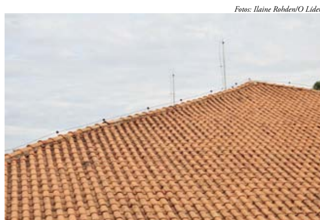
Instalação de pára-raios proporciona maior segurança ao local
