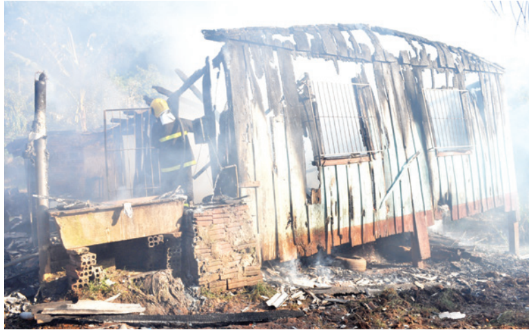
A residência ficou totalmente destruída
