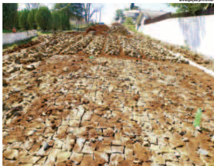
Obras iniciaram no mês setembro e devem ser concluídas em breve
